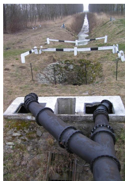
A Tólaposi-csatorna torkolatában lévő tiltós műtárgy és szivattyúállás 2008. januárjában
