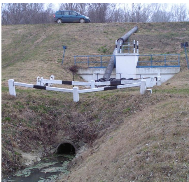
A Tólaposi-csatorna torkolatában lévő tiltós műtárgy és szivattyúállás 2008. januárjában
